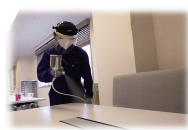
物件名：凸版印刷 事務所（文京） 基材：クロス、デスク、テーブル等 用途目的：抗菌、抗ウイルス、防臭 施工日：2020年5月
